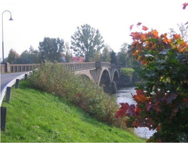
Kuva 1. Kokemäenjokea ylittävä kivisilta (kuvannut Ritva Annala).
